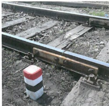
Obr. 2 umístění návěstidla k upozornění na hranici izolovaného úseku
